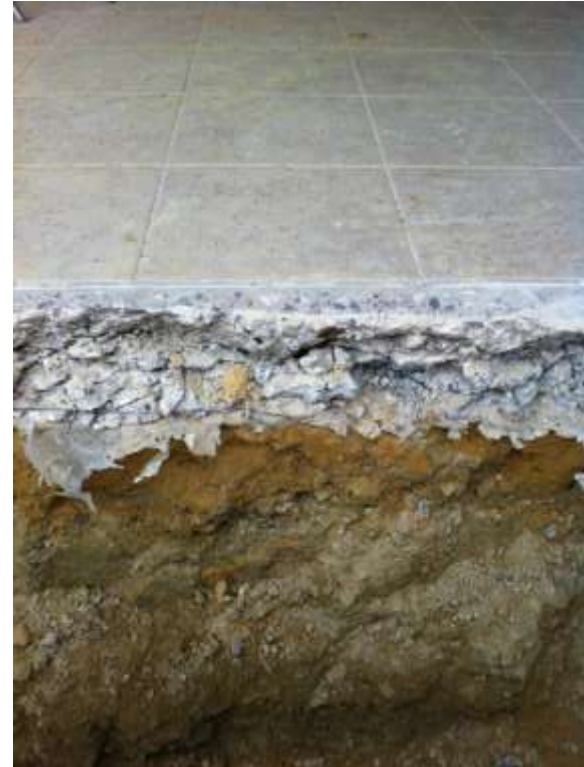
Complexe revêtement / Pose scellée interdite en locaux P4s (mai 2010)
