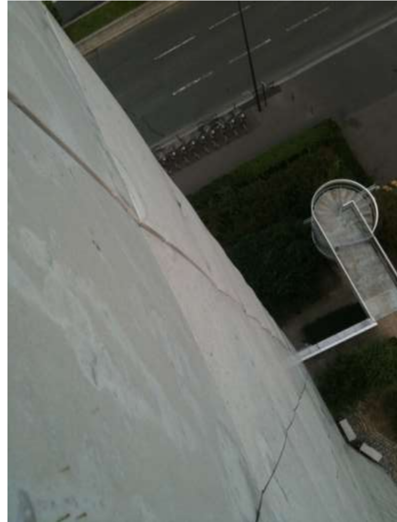
Déformation Pierre agrafée en façade. Tuilage vertical
