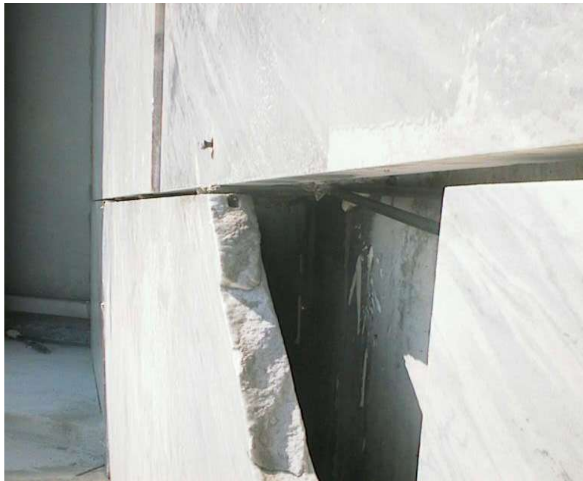
Tuilage des pierres en façades / Mode d'attache et vide d'air
