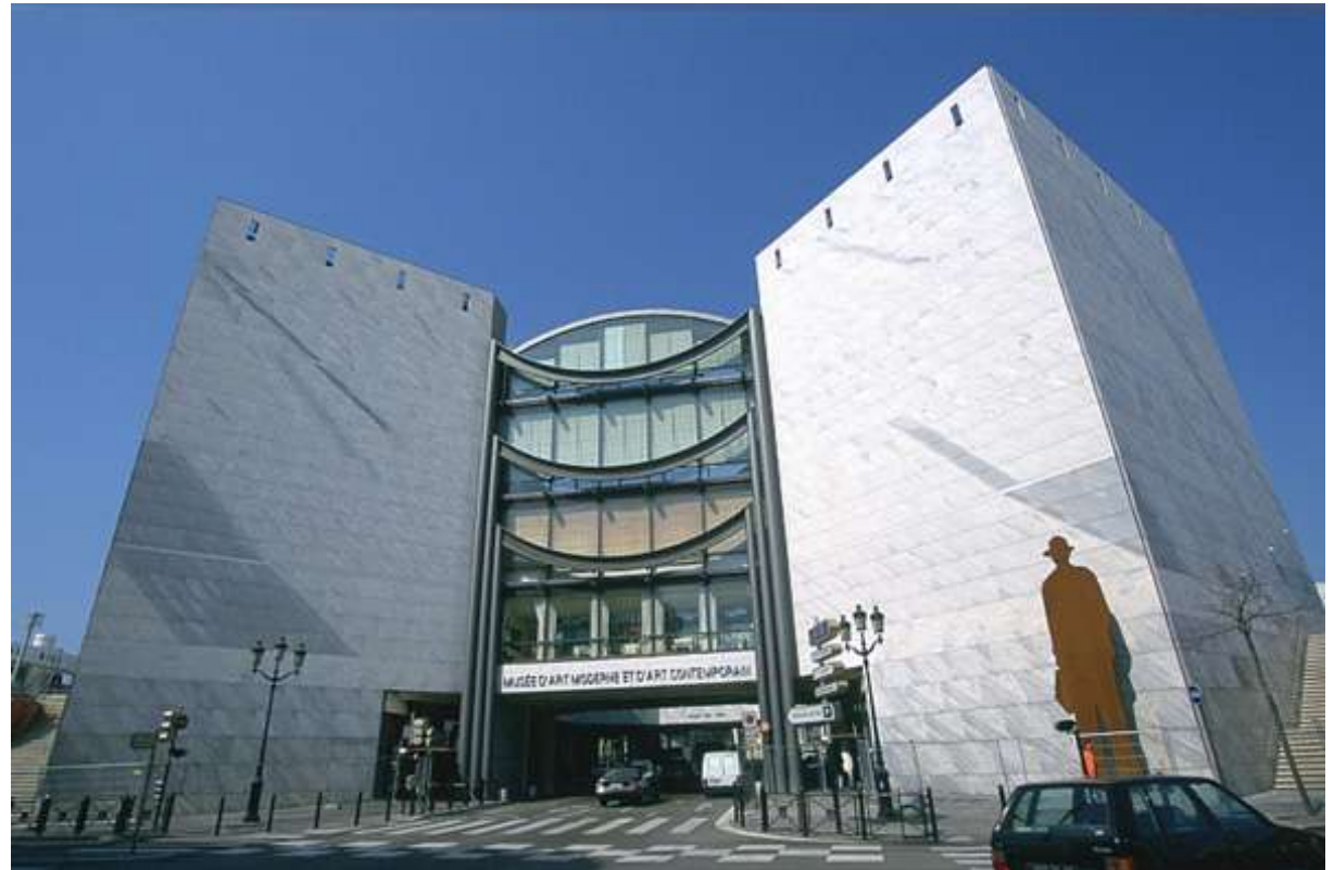
Tuilage horizontal des pierres en façades
