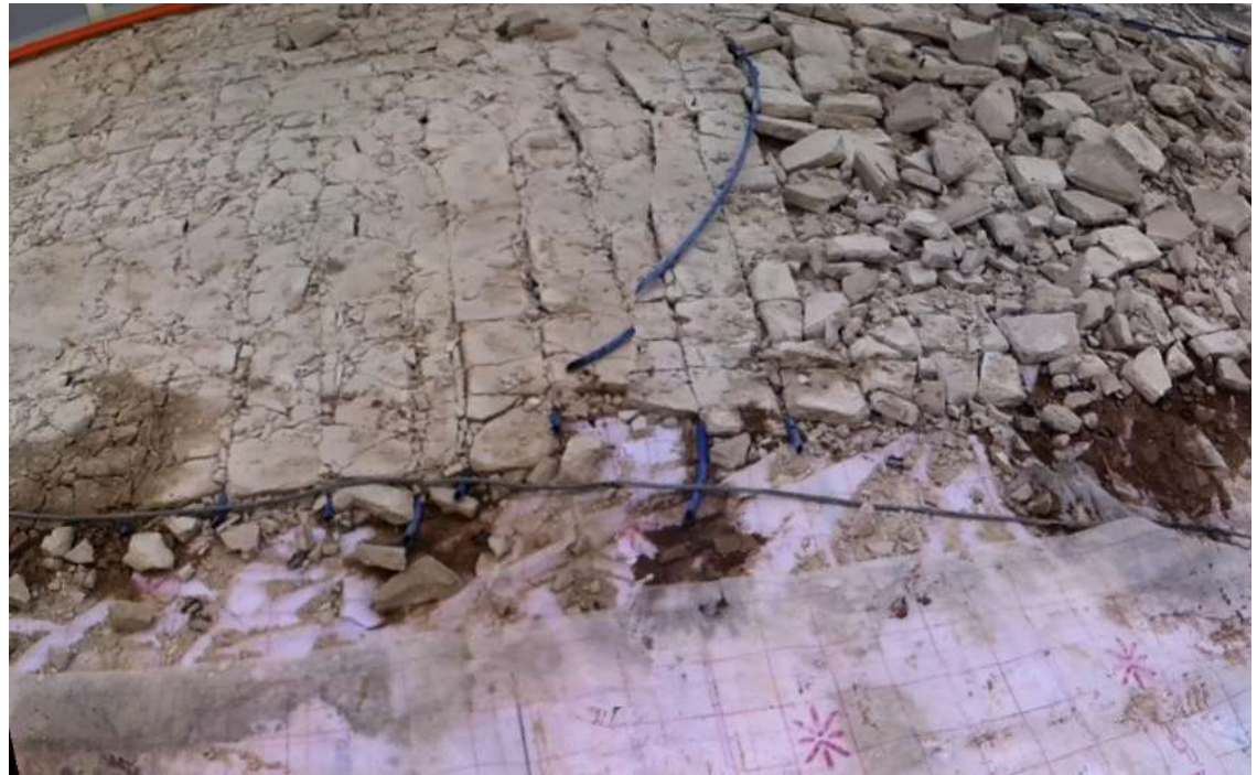
Fragmentation d'une chape anhydrite de faible épaisseur, traversée par un serpentin chauffant/refroidissant, sur isolant
