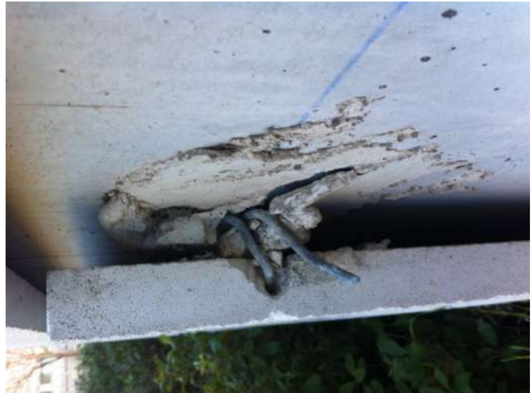
Défaillance de l'attache d'une pierre agrafée
