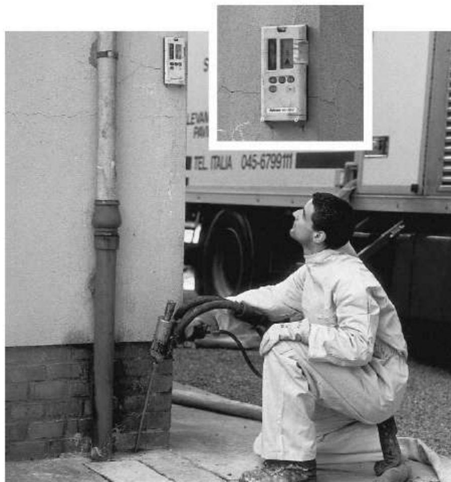
Photo n° 2 : opération de stabilisation d'un bâtiment avec contrôle de niveau (photo UIRETEK).
