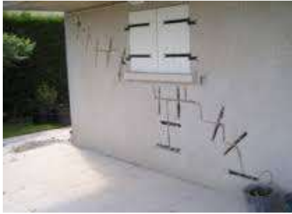
Traitement de la maçonnerie
