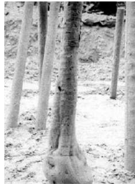
Photo n° 10 : micropieux excavés (photo projet national Forever).
