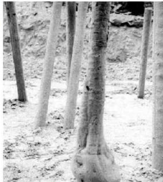
Photo n° 10 : micropieux excavés (photo projet national Forever).
