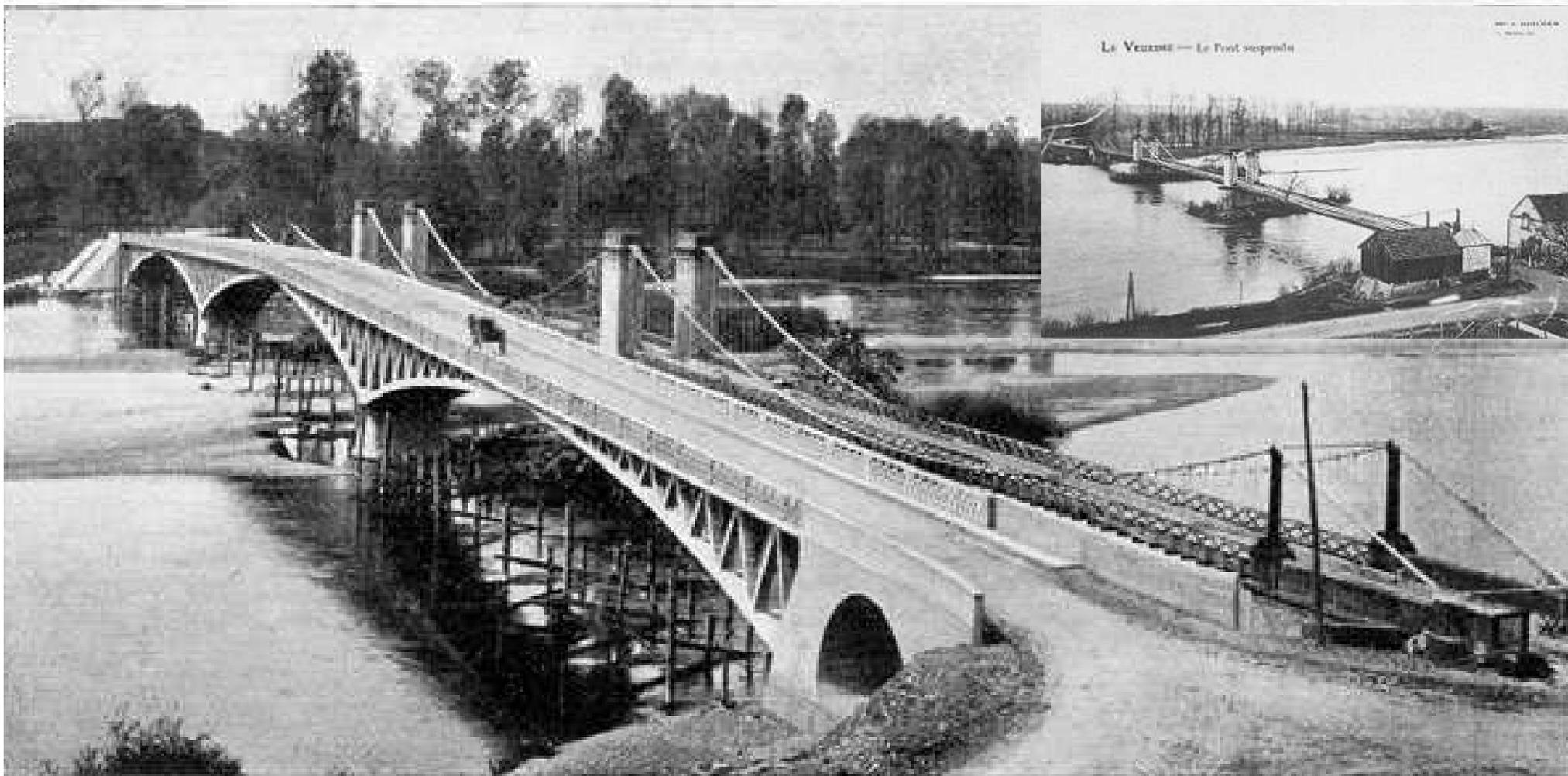
PONTÉES.. { Arche centrale.. 72<sup>m</sup> 50 } à triple articulation { au sommet une rotule métallique,
