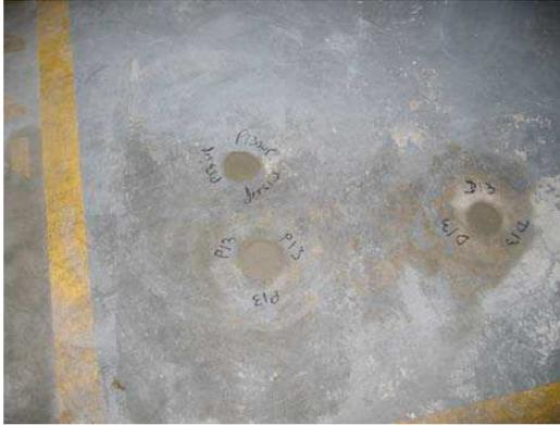
**Figure 5 : Reboilage des forages et marquage en surface supérieure**
