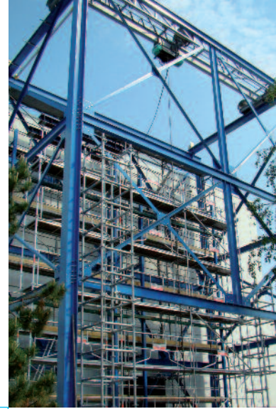
Station d'essais de grandes structures
