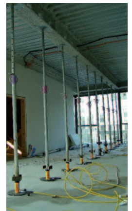
Essai in situ
