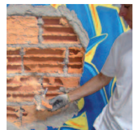
Essai d'arrachement in situ
